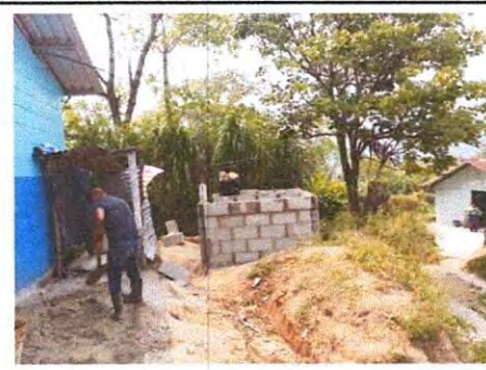
Foto 12: Sustitución de paredes de baño de lámina por block.
