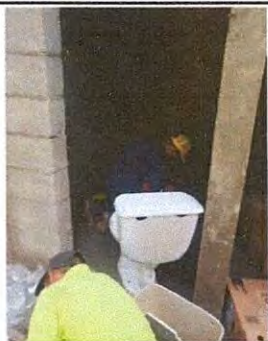
Foto 11: Sustitución de letrina por baño de cerámico.
