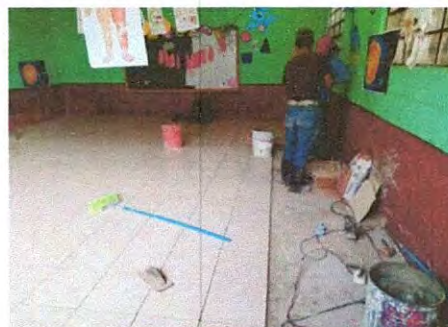
Foto 10: Sustitución de piso de torta por piso cerámico aula de preprimaria.
