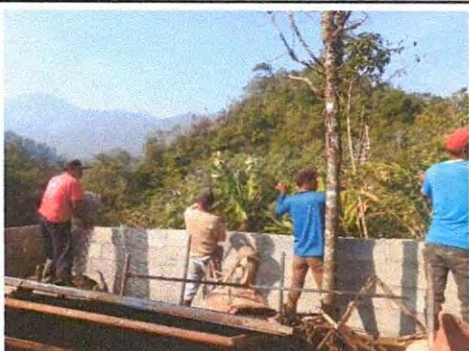
Foto 3: Sustrucción de un metro malla por muro perimetral de la parte de atrás del centro educativo.
