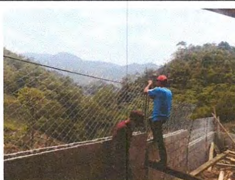
Foto 2: Sustrucción de un metro malla por muro perimetral de la parte de atrás del centro educativo.
