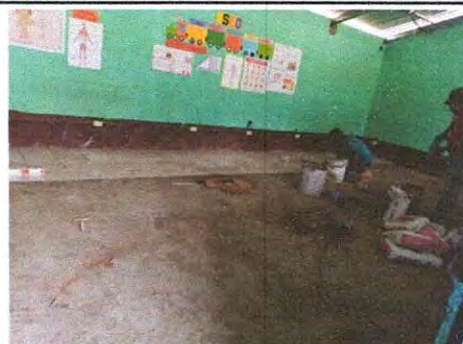
Foto 6: Sustrucción de piso de torta por piso cerámico aula de tercero.
